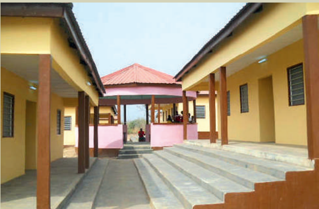
▲ Togo: Einige Gebäude des neuen Blindenzentrums in Kadambara im Jahr 2013
